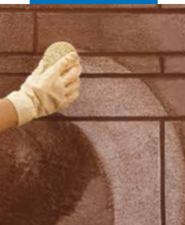
Окончательная очистка плитки с помощью губки
