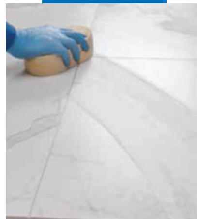
Окончательная очистка плитки губкой
